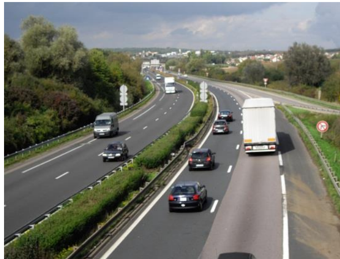
Autoroute A31 à Guénange
